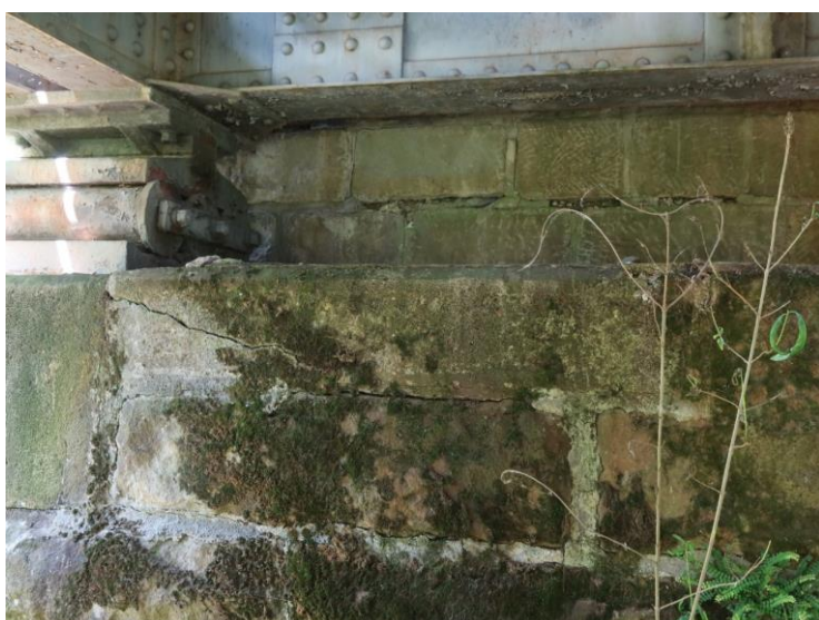
Foto č. 3 Opěra O 02 – úložný práh vlevo trhлина
