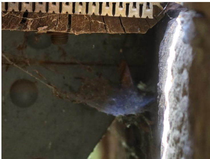
Foto č. 1 Konstrukce K 01 – levý podélník - naražení na závěrnou zeď opěry O 02
