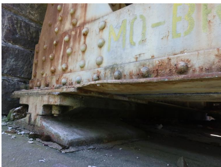
Foto č. 2 Konstrukce K 01 pravý hlavní nosník nad O 01 deformace dolní pásnice
